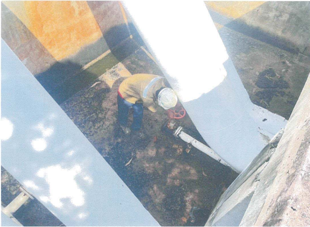
STT 5 พนักงานซ่อมบำรุงเปิด Valve 4 นิ้ว ที่ End Line ท่อ 24 นิ้ว เพื่อ Dain น้ำมัน ในท่อที่บ่อกักเก็บน้ำมันจุด Low Point
