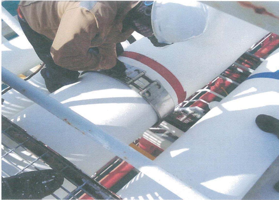
STT 9 พนักงานซ่อมบำรุงนำ CAMP รัศต่อ 24 นิ้ว ที่จุดรั่วไหล เพื่อหยุดการหกรั่วไหลของน้ำมันลงทะเล
