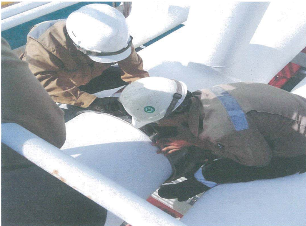
STT 6 พนักงานซ่อมบำรุงนำ CAMP รัศท่อ 24 นิ้ว ที่จุดรั่วไหล เพื่อหยุดการหกรั่วไหลของน้ำมันลงทะเล
